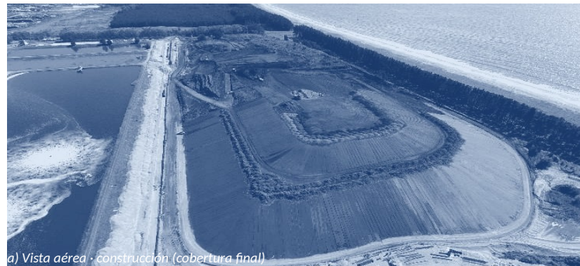
a) Vista aérea • construcción (cobertura final)
