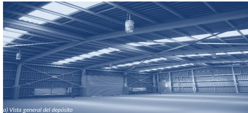
a) Vista general del depósito
